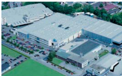
MAHLE Industriefiltration, Werk Öhringen
